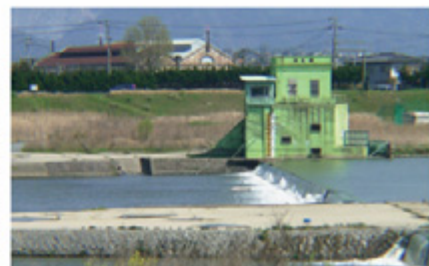
④ 遠賀川の豊富な水量を汲み上げるポンプ場
