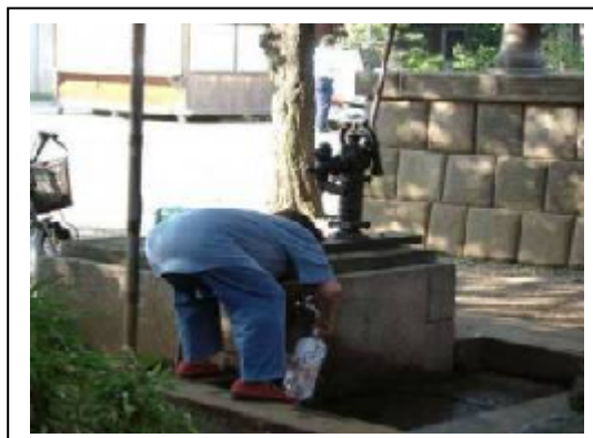
図 - 5 手押しポンプ
