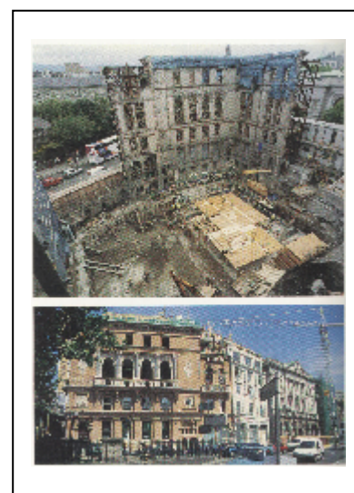
図 2（ダブリン市内の外壁保存現場）
