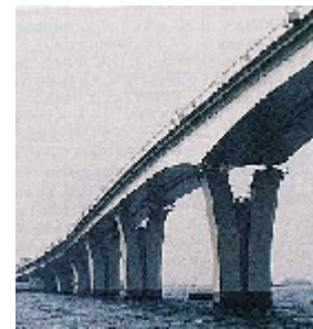
東京湾横断道路（アクアライン）の橋脚に使用されたチタンクラッド
