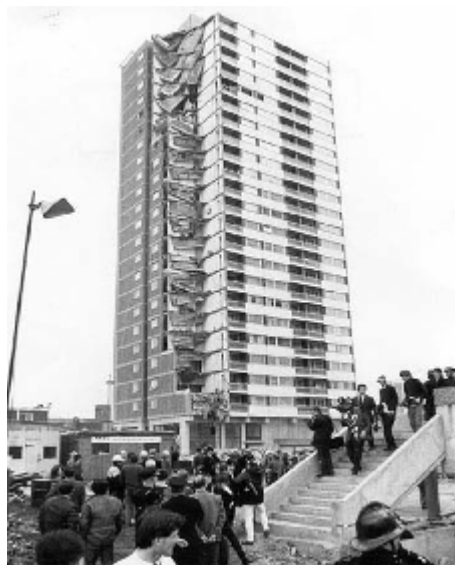
図 8 1968 年 5 月のガス爆発後のロナン・ポイント高層ビル
