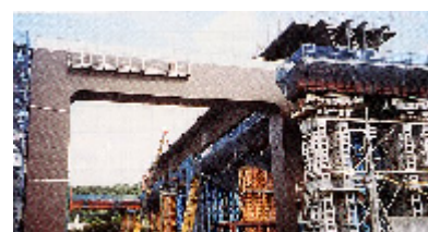
海浜鋼で造られた北陸新幹線「北陸道架道橋」
