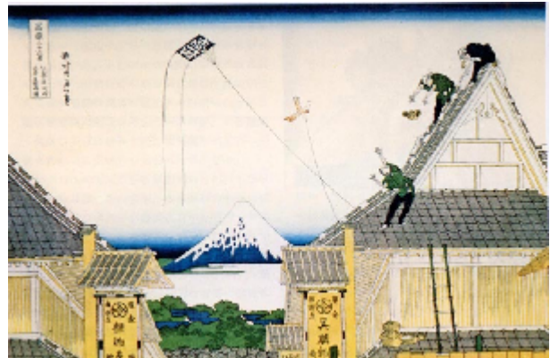
図3 富岳36景にみる屋根瓦の補修風景（北斎）
