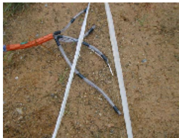
センサーの埋設後
