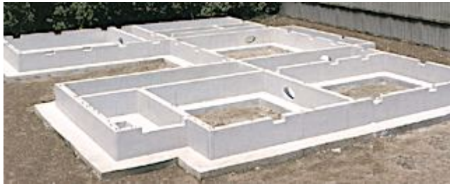
不同沈下を防ぐ鉄筋コンクリート連続布基礎
