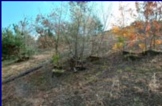
施工後5年 簡易法面植栽柵の原型が残る
