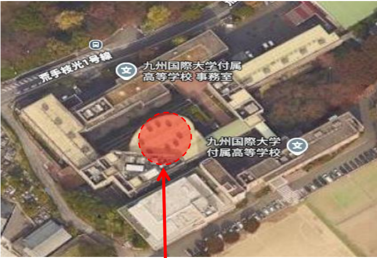
枝光キャンパスC棟5階厨房食堂
