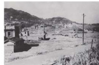
24 戦後直後の現国道 3 号。道幅が今と全く違います。
