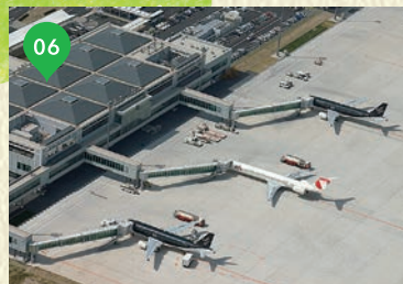
国内、アジアを結ぶ24時間運用の国際空港 北九州空港
